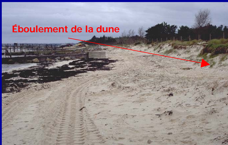
Des engins qui passent trop près de la dune et qui la déstabilisent
