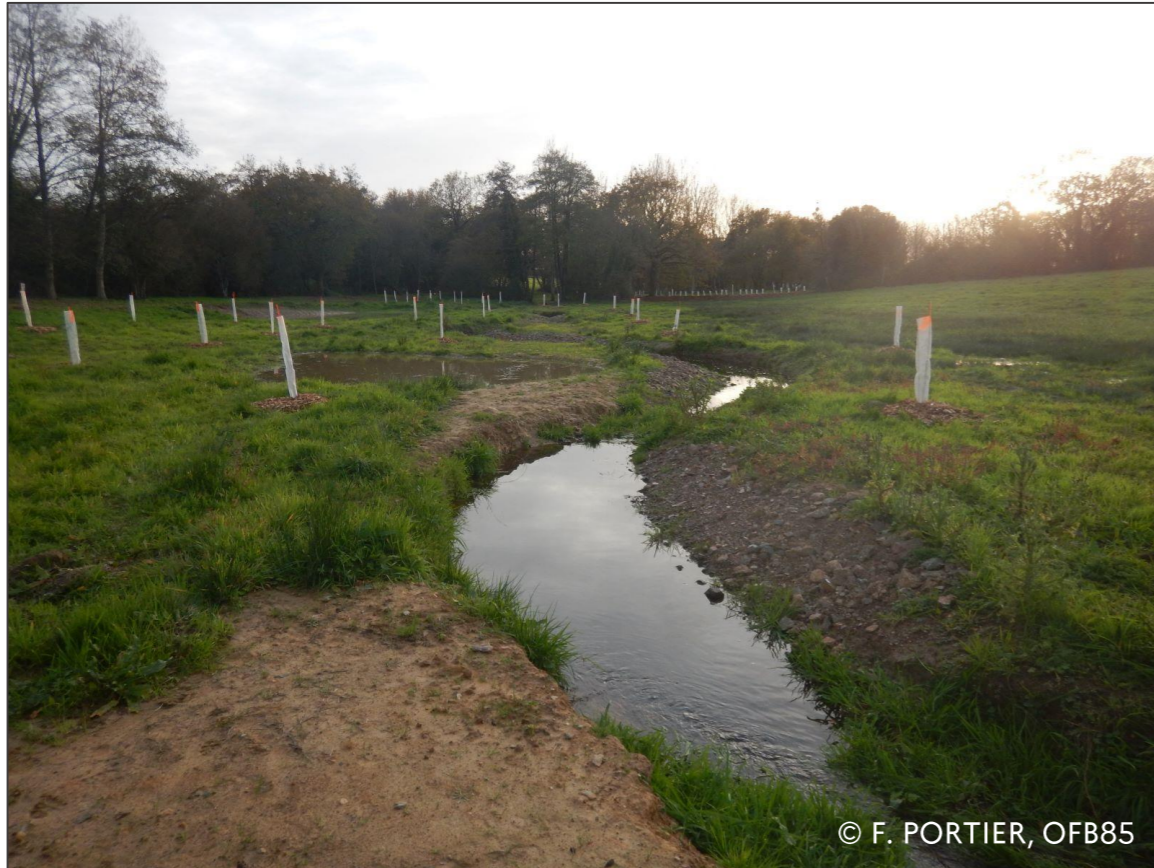
Exemples de retalutage des berges
