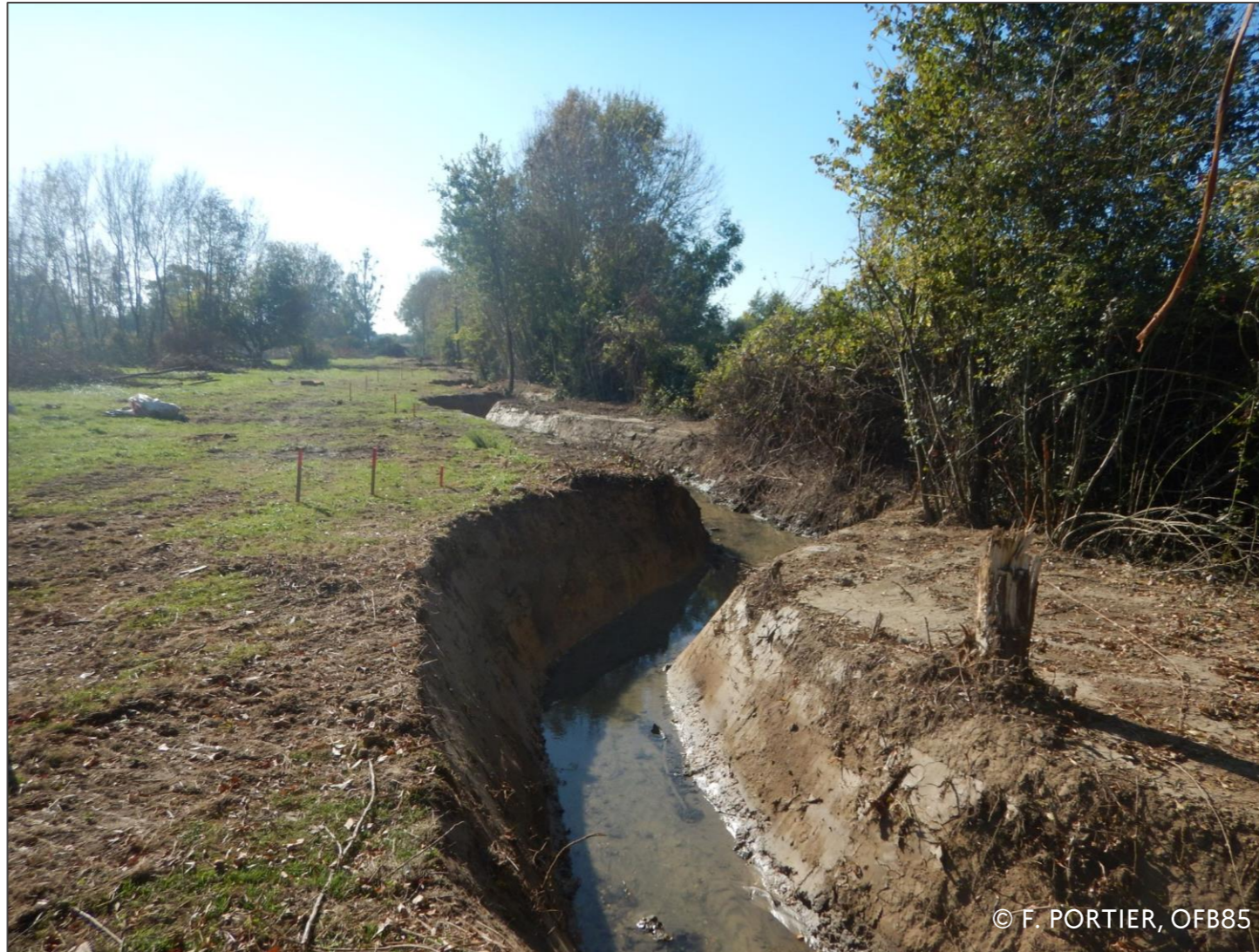
Exemple de ripisylve enlevée en rive gauche
