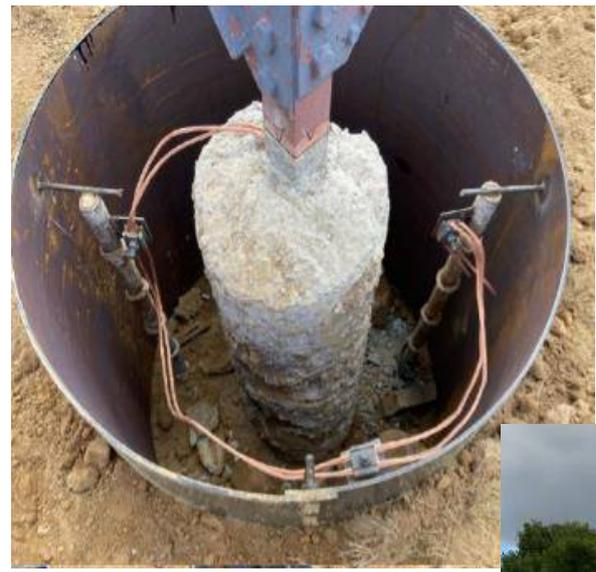
Mise en place des viroles et coulage du béton
