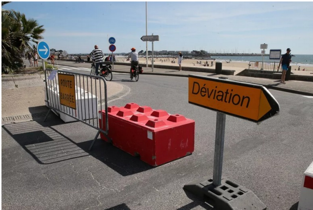
Pornichet : une partie du remblai réservé aux piétons et vélos
