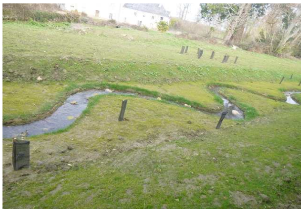
Figure 4 : Exemple de réalisation d'un lit emboîté sur un cours d'eau en tête de bassin versant (source : Le Bihan)
