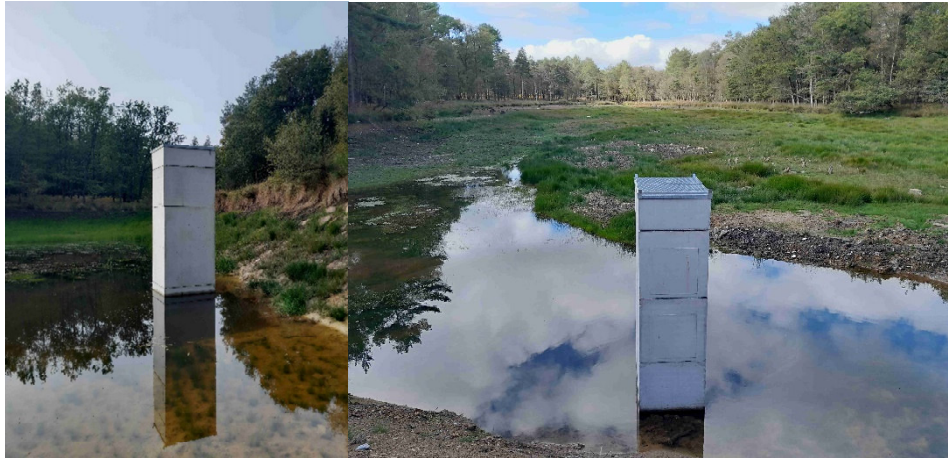
Figure 6 : Plan d'eau en cours de remplissage suite à l'installation de moines sur des plans d'eau préexistants (© HUBERT & LE BIHAN, OFB, 2024 ; Forêt de Lanouée, 56).
