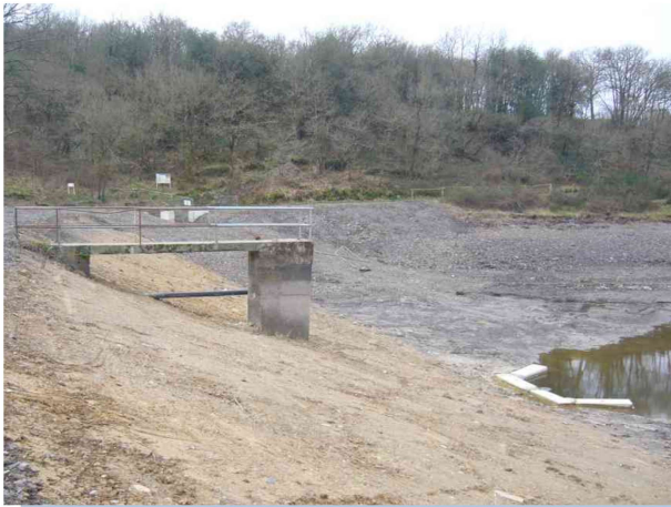
Barrage de Saint-Blaise (49) © DREAL PdL
