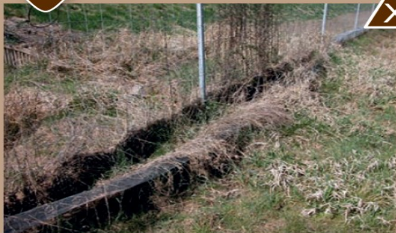
Clôture amphibien affaissée par le poids de la végétation. Source : Cerema.
