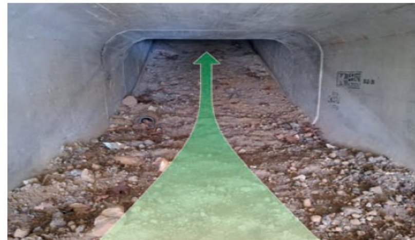
Passage petite faune en pente sur une infrastructure située au niveau du terrain naturel. Source : Cerema.
