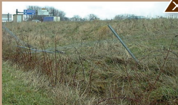
Clôture dégradée lors d'un accident de la circulation. Source : Cerema.
