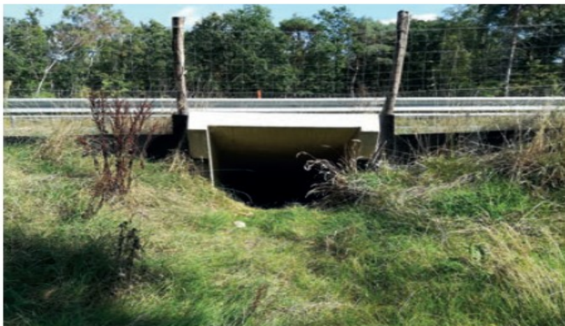
Passage petite faune en pente sur une infrastructure située au niveau du terrain naturel. Source : Cerema.
