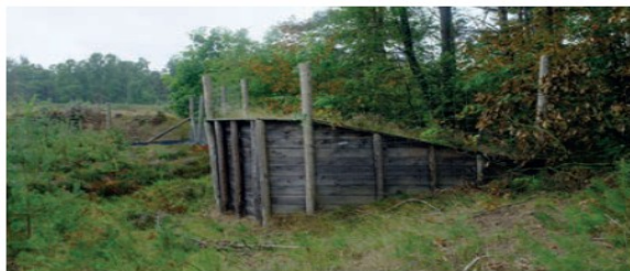
Échappatoire avec un système de rampe simple (Pays-Bas). Source : Vinci Autoroutes.
