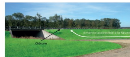
Clôture positionnée au plus proche de la route et permettant le libre accès des dépendances vertes à la faune. Source : Cerema.
