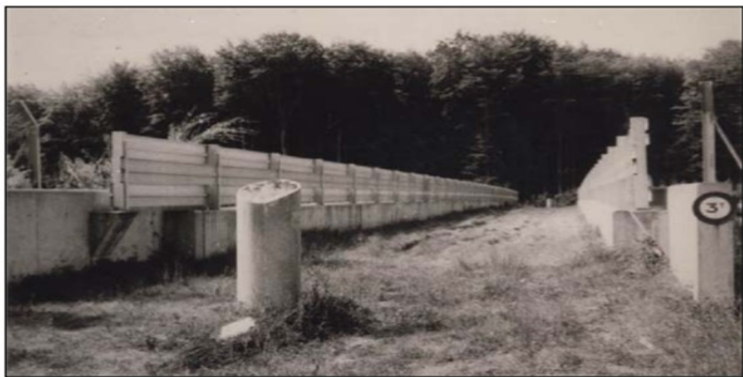
Autoroute A13, Forêt de Bord largeur 4m50
