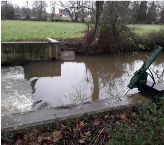
Clapet vue depuis la rive gauche. Janvier 2023
