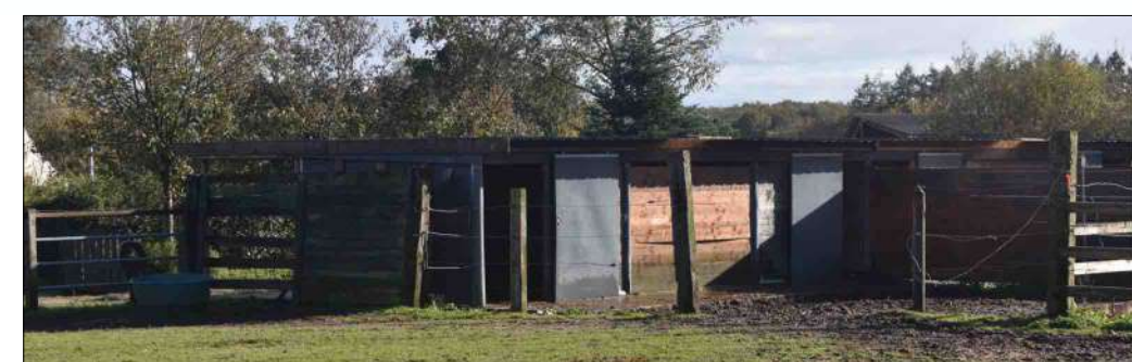
Vue Sud Ouest
