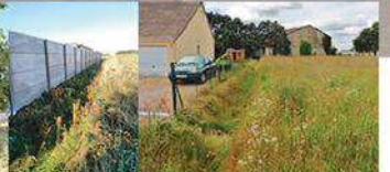
11 Mur plaque Riverain Sud Fossé recueillant les eaux de ruissellement de la parcelle. L'urbanisation du secteur rendra le besoin obsolète
