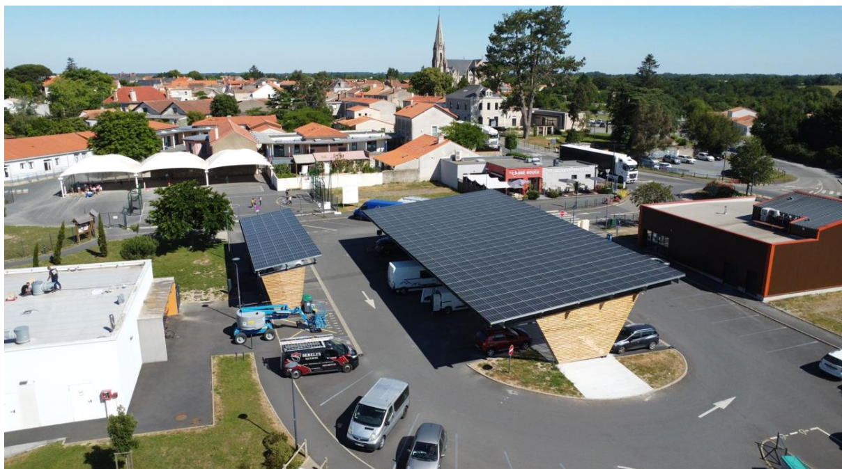
Ombrières avec bardage bois
