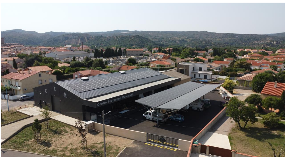
Ombrière « Papillon » couvrant un centre technique + toiture
