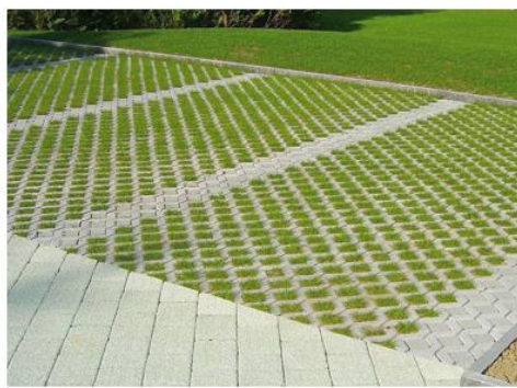
places de stationnement dalles béton alvéolées
