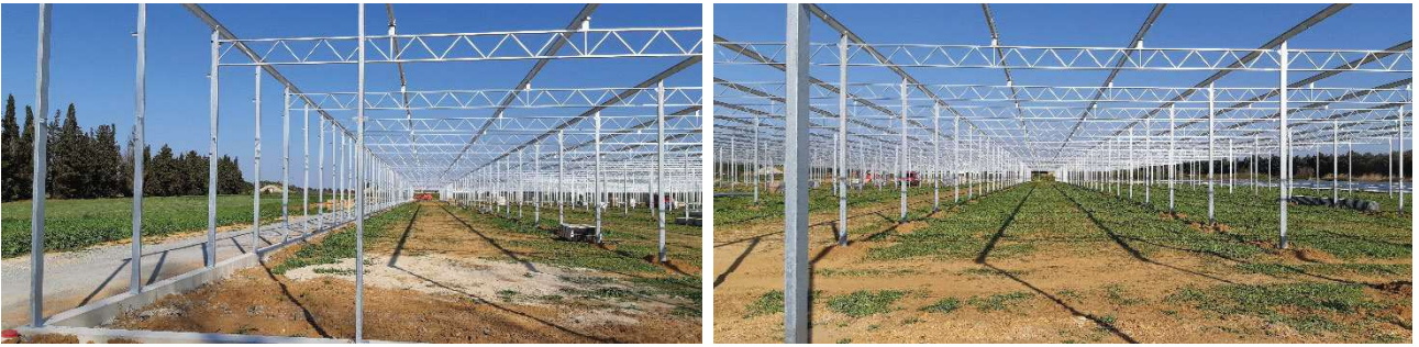
Figure 14 : Montage structure d'une serre photovoltaïque (source : Reden).
