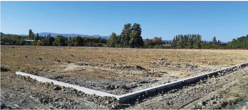
Figure 16 : Fondations béton extérieures (longrine) (source : Reden).
