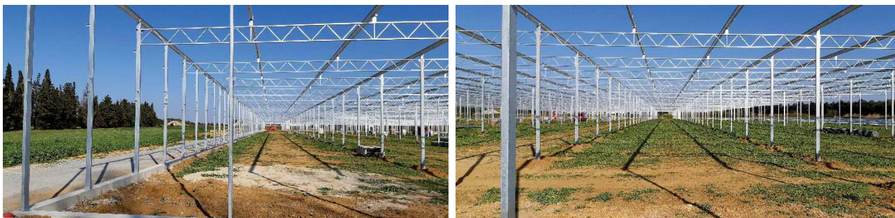
Figure 22 - Montage structure d'une serre photovoltaïque. Source : Reden Solar.
