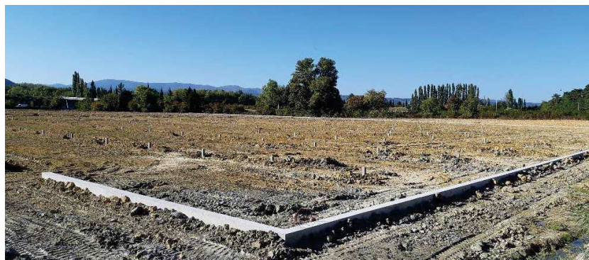
Figure 24 - Fondations béton extérieures (longrine). Source : Reden Solar.
