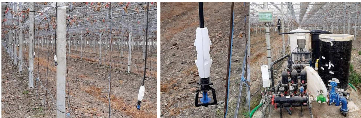
Figure 17 - Exemple de système d'irrigation par aspersion et goutte à goutte de cultures de kiwis rouges sous serre photovoltaïque. Source : Reden, 2021.
