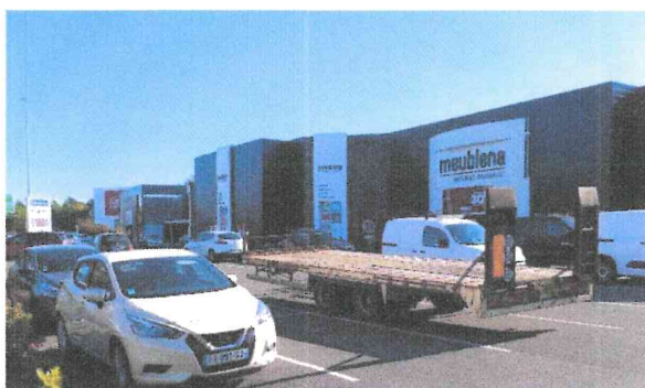
Démolition du bâtiment existant et décroutage des enrobés
