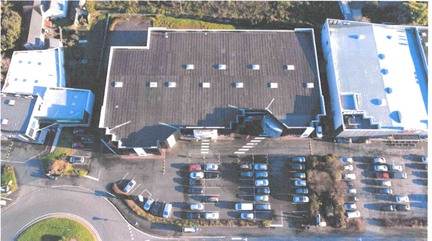
Vue du toit et du parking du bâtiment étudié
