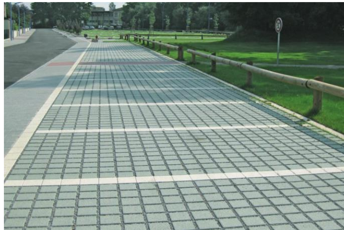
Pavé drainant Ecoroc - 20x20 cm - ép. 8 cm - avec écarteur 15 mm de chez Marlux ou Pavé Herbaturf 20x20cm ép. 8 cm avec écarteur 15mm de chez Kronimus > joint gazon ou joint minéral (gravillon, sable clair) 'Compatible PMR'
