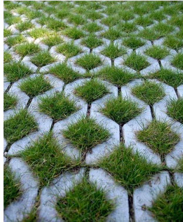
Dalle béton préfabriquée type 'FEBESTRAL' > joint gazon ou joint minéral (gravillon, sable clair)
