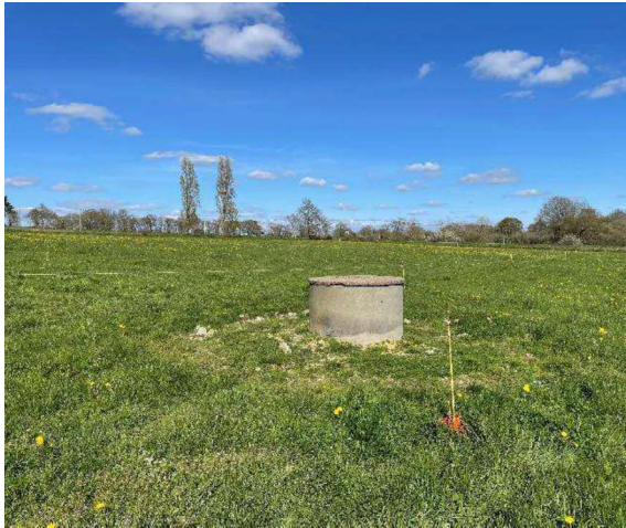
Vue sur le puit et sur l'emplacement du nouveau forage (piquet jaune)
