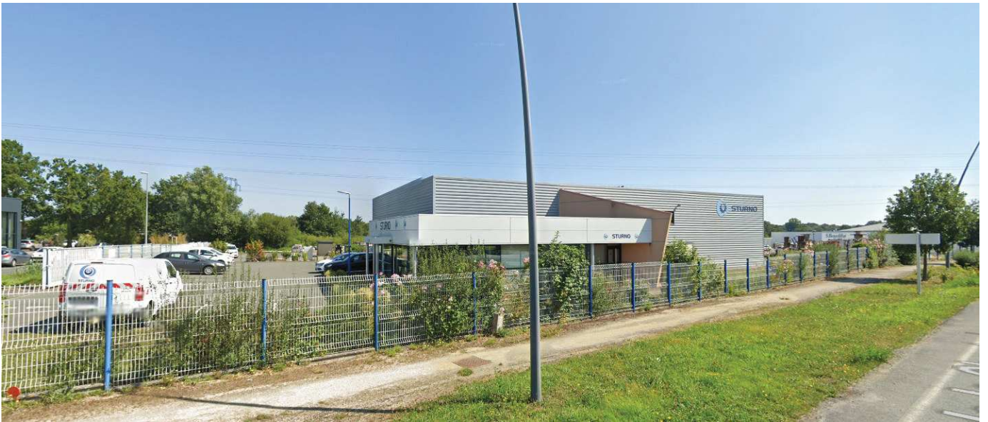
Vue 1 : Site de l'entreprise vu depuis le Sud (Boulevard de Chanterie)
