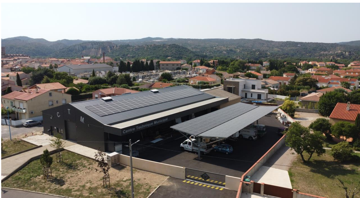
Ombrière « Papillon » couvrant un centre technique + toiture
