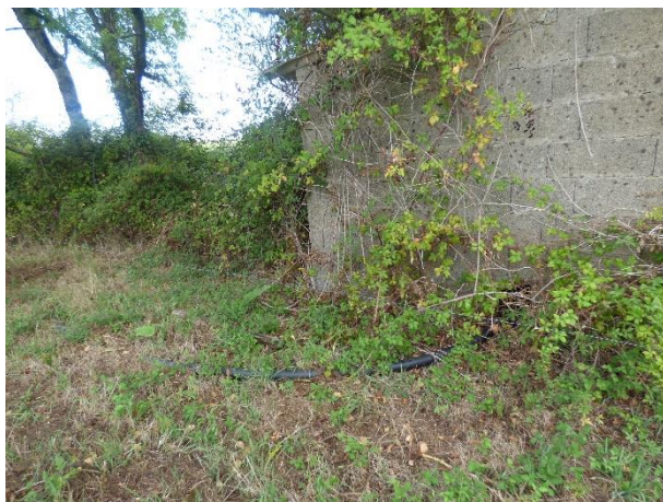
Fig. 4. Structure agricole isolée : cabane de pompage
