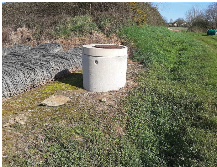
F1 existant (vue nord)
