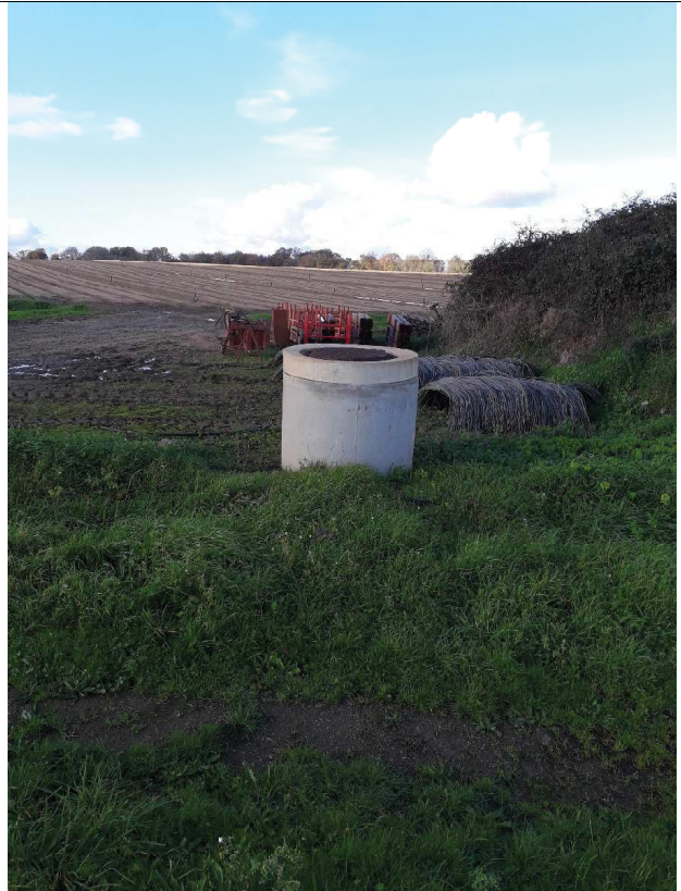
F1 existant (vue ouest)
