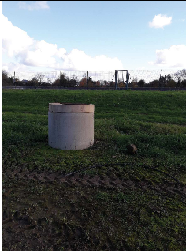
F1 existant (vue sud-est)
