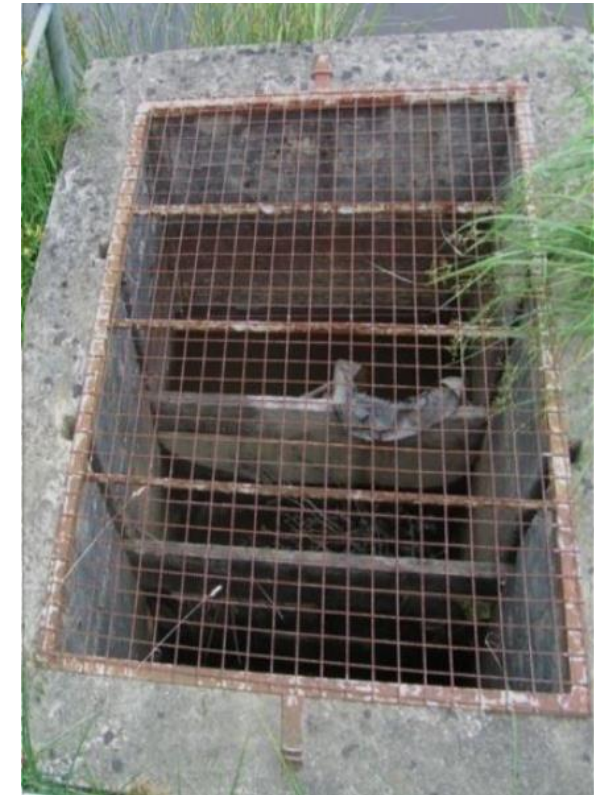
Photo du moine d'un plan d'eau sur les sources de l'Utreil.
