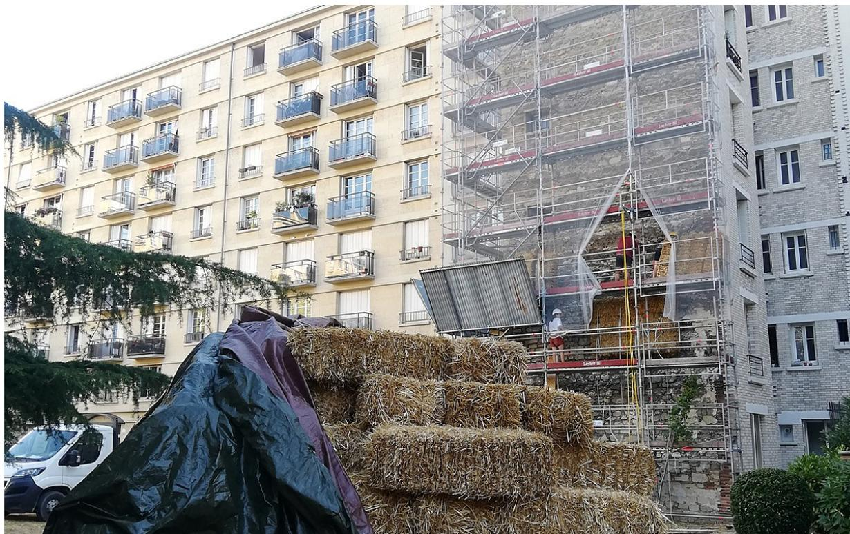
Techniquement, au niveau des étages inférieurs, une méthode dite d'accroche par bretelles est utilisée : les bottes de paille sont posées horizontalement à l'aide de bretelles, des sortes de sangles qui sont normalement utilisées sur les palettes pour fixer les marchandises. Aucune ossature en bois n'est nécessaire, et la pose est rapide. Un enduit recouvrant est ensuite appliqué.
