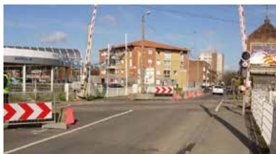
Chantier à proximité d'un PN (source : SNCF)
