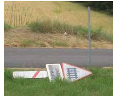
Signalisation dégradée (source : Cerema)
