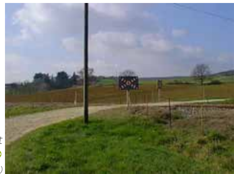
PN sans barrière et sans STOP (cat2) → (Source : Cerema)
