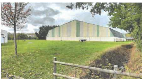
4 – Partie centrale du site, vue vers le sud-ouest (à droite le gymnase et à gauche la salle M. Berger).
