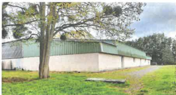
2 – Partie nord-ouest de l'emprise à réaménager (arrière du gymnase J. Anquetil) vue vers le sud-est.
