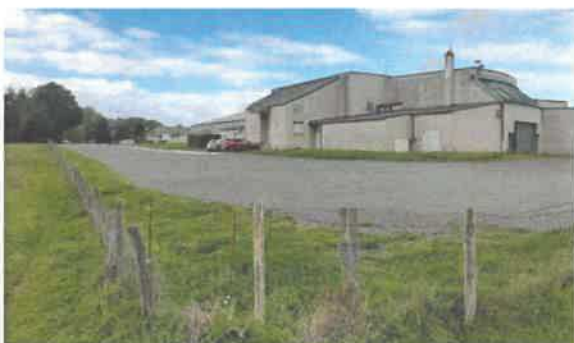
6 – Partie sud-est de l'emprise vue vers le nord-ouest (parking et salle M. Berger devant et gymnase derrière).
