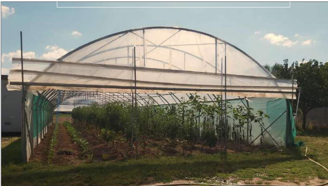
Serre tunnel existante
