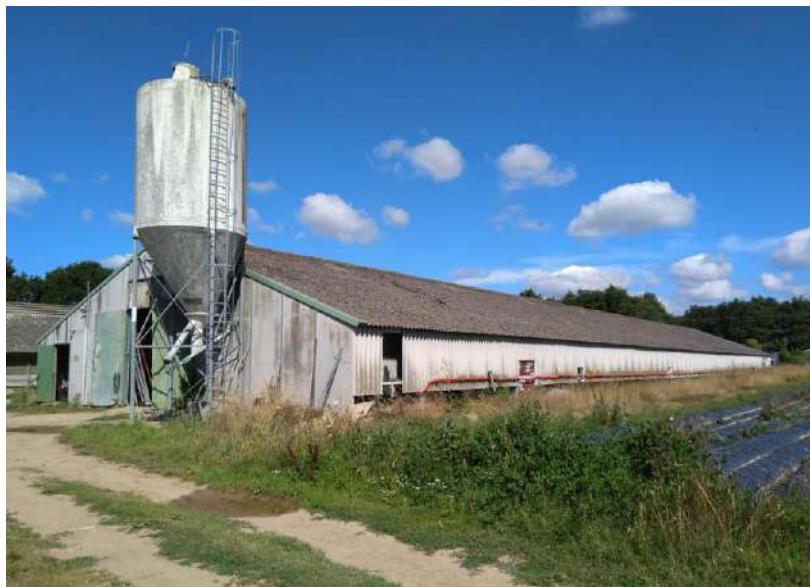
Illustration 23 : Bâtiment agricole à l'Ouest de l'emprise destinée à l'implantation de la serre photovoltaïque
