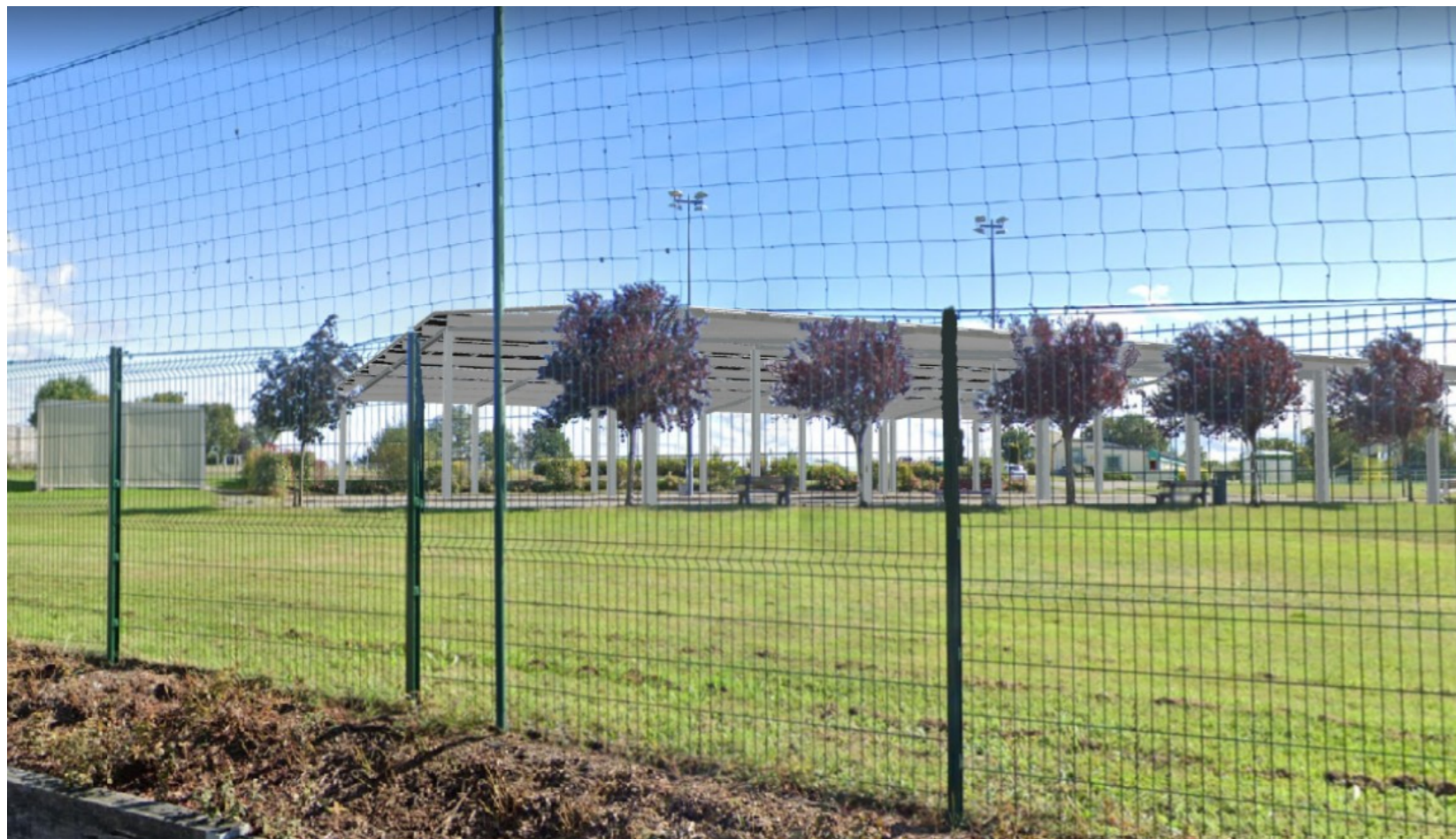
VUE NORD-OUEST - Ombrière 1
