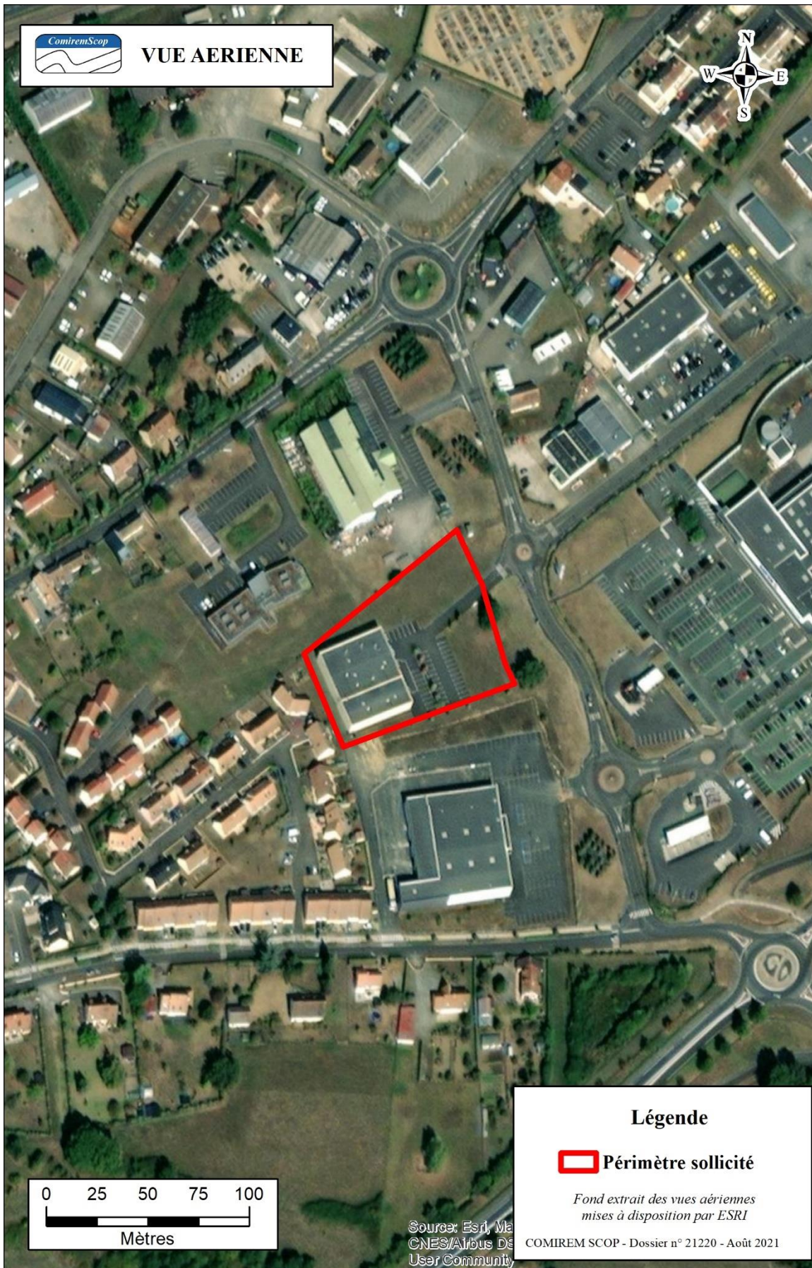
Figure 3 : Localisation du site sur photo aérienne
