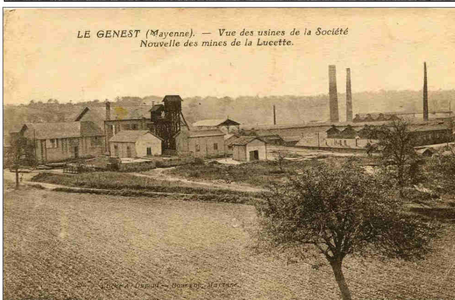
Figure 20 : Vues des installations de traitement de la nouvelle usine depuis la prairie sud (haut) et la prairie est (bas) (source : Delcampe.net)
