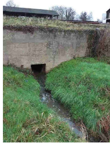
H - Fossé d'eau pluviale en sortie usine (EAU-11/SED-11) – février 2022
