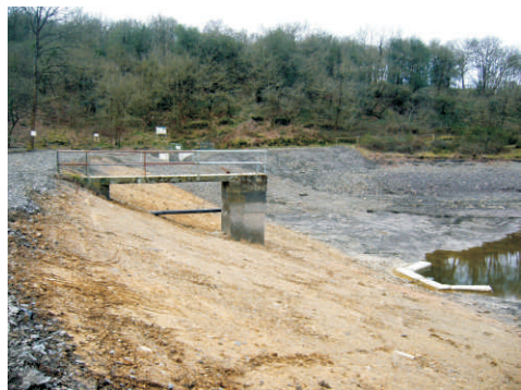
Barrage de Saint-Blaise (49) DREAL Pays de la Loire
