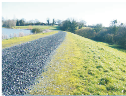
Barrage de la Morinière (53) DREAL Pays de la Loire
