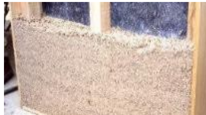
Banchage en doublage & cloison
