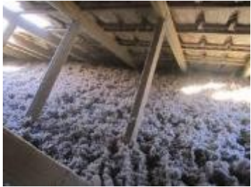
Vrac en combles perdus
