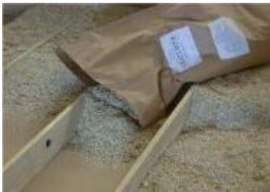
Vrac en combles perdus
