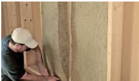
Remplissage d'ossature bois et isolation intérieure
