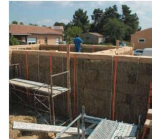
La botte de paille a ici un rôle structural en plus d'être un isolant thermique. Il n'y a pas d'ossature bois, ce sont les bottes de paille qui portent la charpente.
