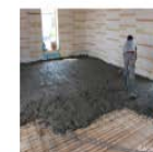
Plancher mixte bois-béton
