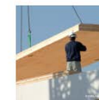
Plancher en panneaux de bois lamé croisé (CLT)
