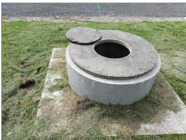
Figure 7 : Tête d'ouvrage du forage F2 (le 08/07/2021)
