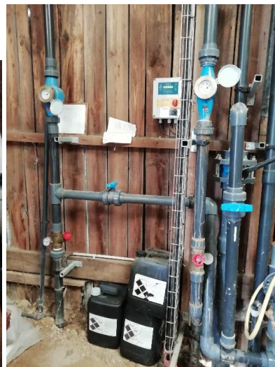
Figure 5 : Caractéristiques de la pompe en place dans F2 (26/07/2021) (à gauche) et système de distribution des forages (à droite)
