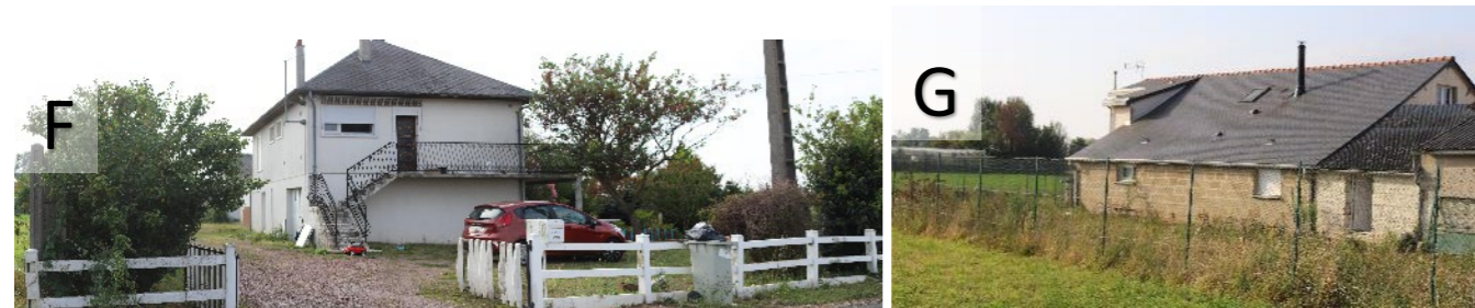
Photo 14 : Les habitations à proximité de la Zone d'Implantation Potentielle
