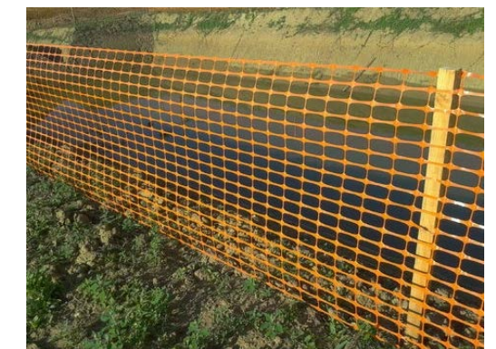
Figure 8 : Exemple de grillage de signalisation orange
