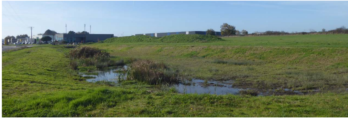
Le bassin de rétention existant
