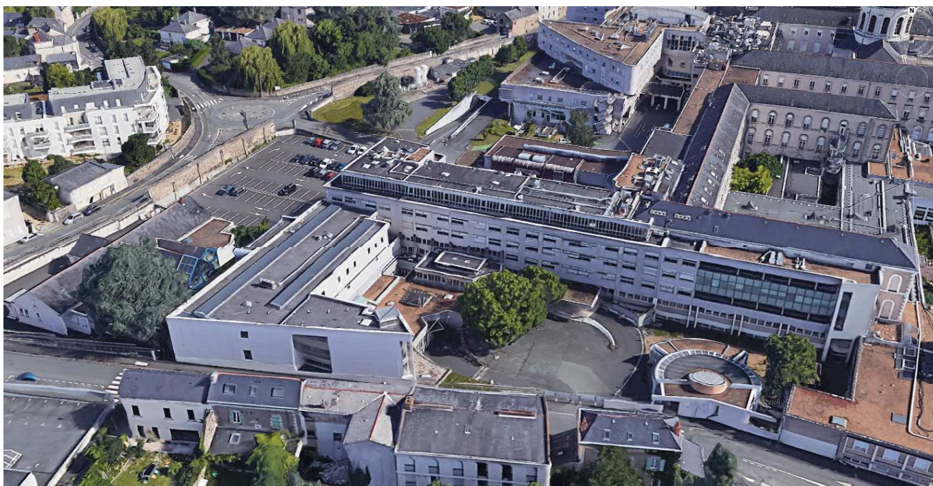
Image satellite Bâtiments 3D issues du site Google Earth – Vue Proche Vue depuis la limite Sud
