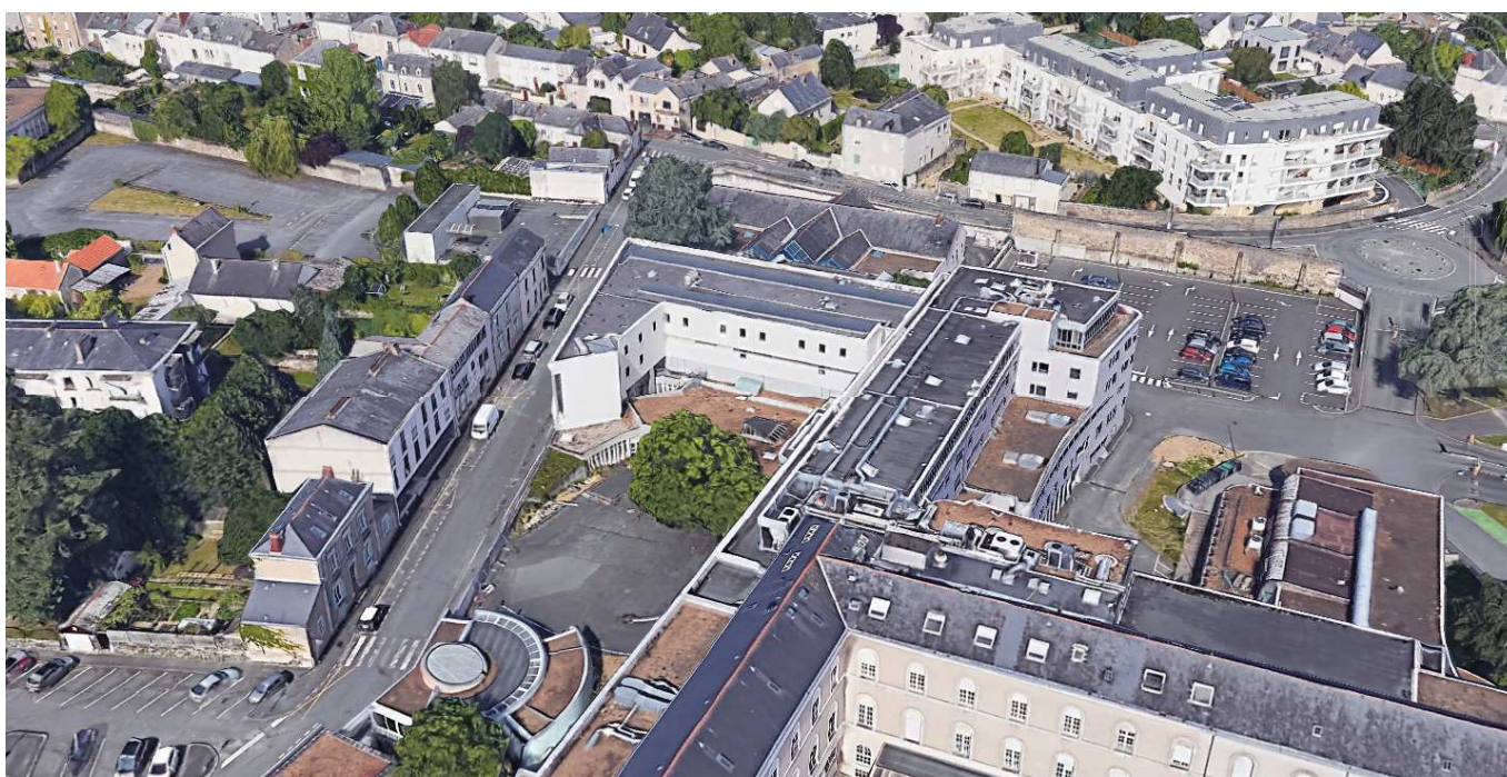
Image satellite Bâtiments 3D issues du site Google Earth – Vue Proche Vue depuis la limite Est
