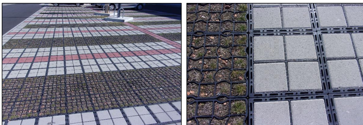
Photo 1 : Exemple de parkings en pavés drainants – Magasin LIDL de Noyal-Châtillon-sur-Seiche
