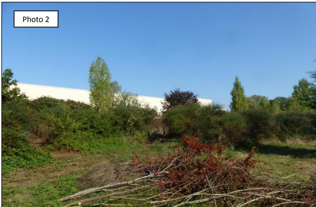
Figure 3 : Vue sur la partie Nord du parcellaire ; l'ancien magasin Mobalpa et ses parkings qui seront démolis dans le cadre de cette opération (photo 1) ; Vue sur la partie basse du parcellaire constituée d'une friche urbaine (photo 2)
