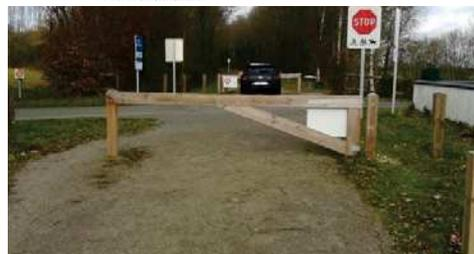
Barrière pivotante déjà réalisée avec poteau d'arrêt
