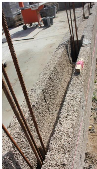
Chainage vertical et horizontal pour une fenêtre
