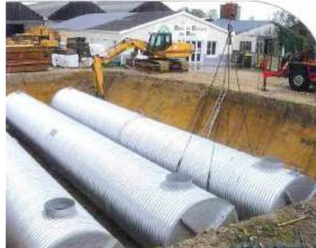
**L'infiltration : cette solution consiste à évacuer les eaux de ruissellement dans le sous-sol, lorsque la nature des terrains le permet.**
