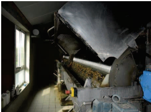
Photographie 13. Prétraitement – Tamis rotatifs
