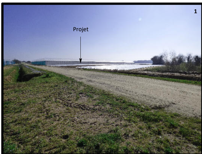
Vue depuis le chemin au nord du site
