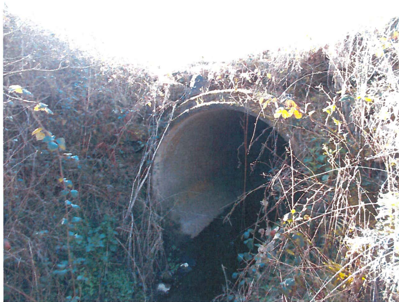
Ruisseau de Bonamy traversant la RD 249
