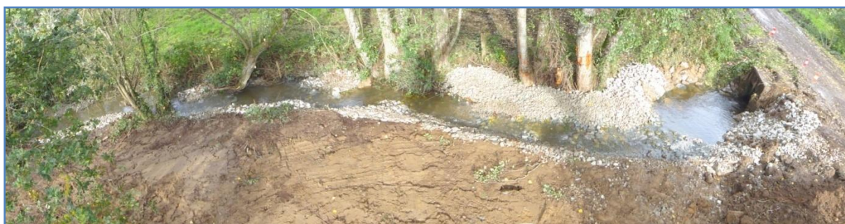
Exemple d'aménagement d'une chute au niveau d'un pont par réalisation d'une recharge granulométrique dans le cadre du précédent programme
