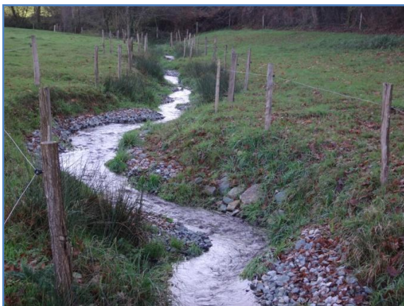
Travaux de reméandrage avec recharge, réalisés sur la Vrillère, dans le cadre du précédent programme.
