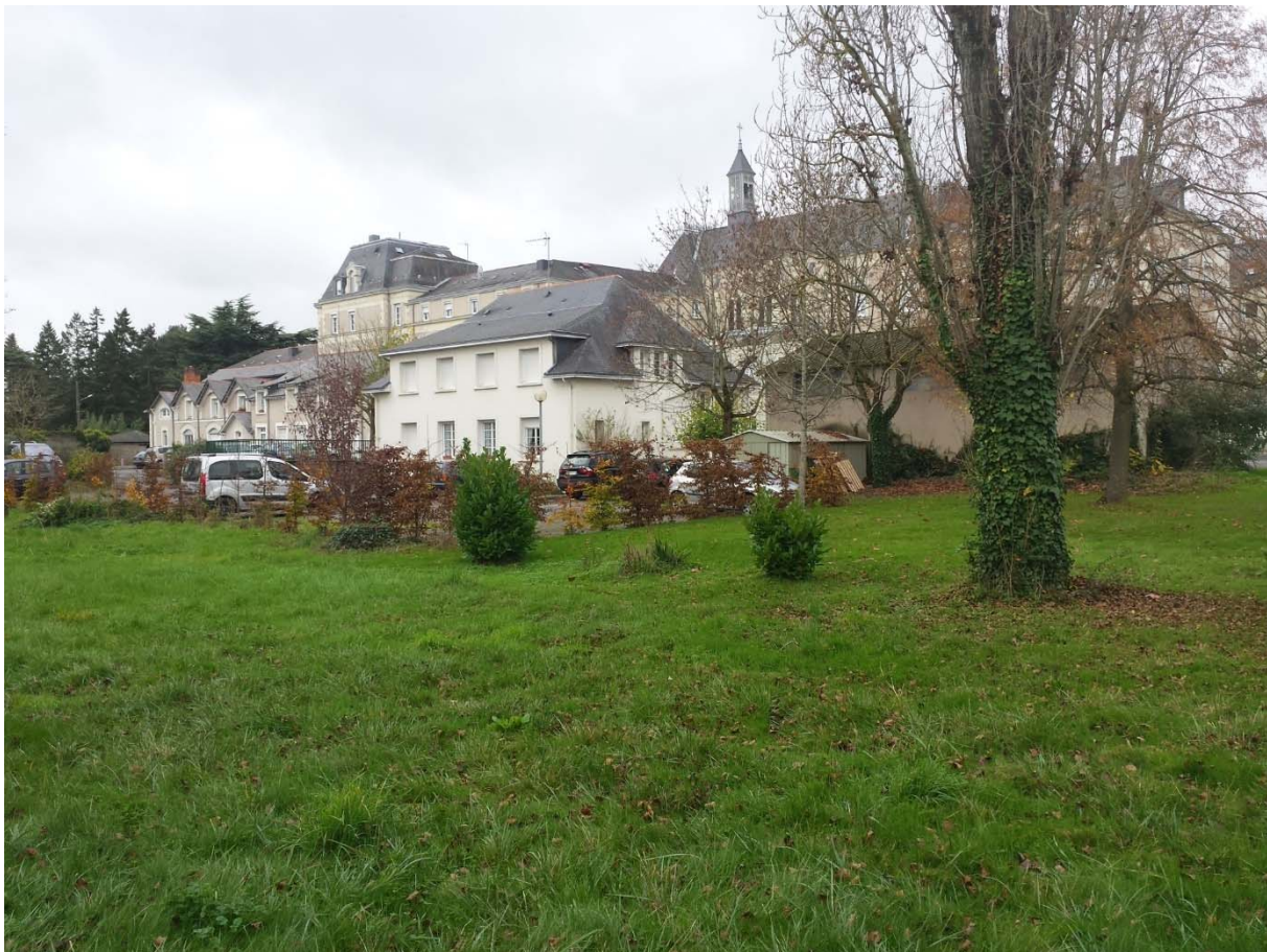
1 – vue de la partie basse Sud Ouest du site
