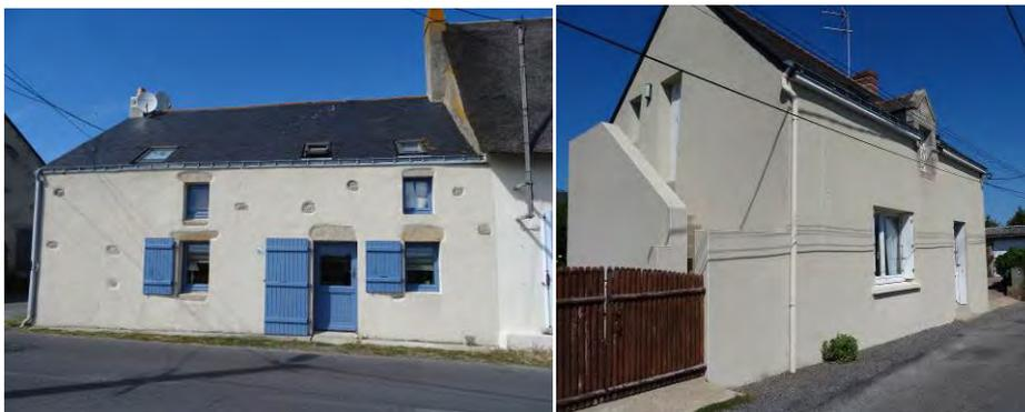
*Détournage des pierres (Queniquen) et enduit gratté avec baguettes (Clis).*
