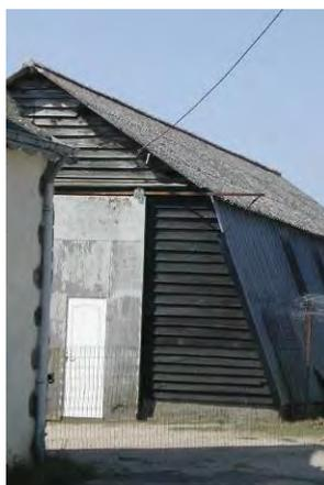
Elles sont construites en maçonnerie de pierre ou en bois. Leur structure est constituée de façon à pouvoir résister à la poussée du tas de sel accumulé à l’intérieur. Pour cela, les murs de maçonnerie sont épais ou épaulés par des contreforts. Pour la même raison, les parois de bois sont inclinées et renforcées par des éléments de charpente parfois situés à l’extérieur. Le bois est toujours enduit de coaltar, comme l’étaient les carènes des bateaux.
